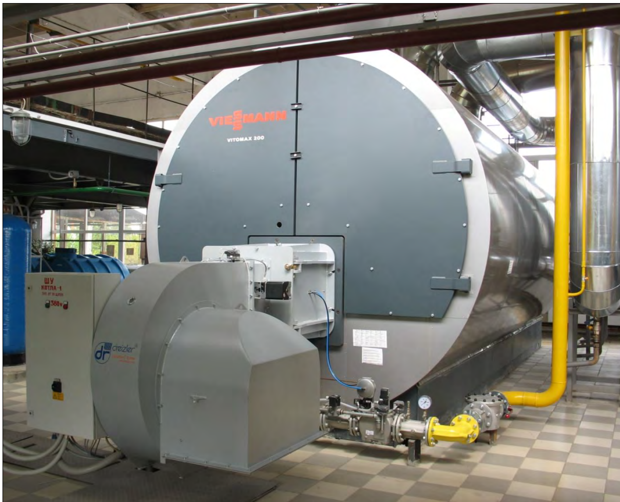
Районна котельня (м. Кременчук): 2 x Vitomax 200 LW 13.800 кВт
