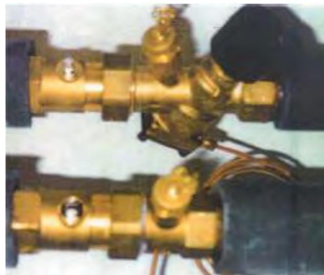
Чтобы гарантировать точное распределение воды, в январе 1996 г. каждый из объектов был оснащен балансировочными вентилями HERZ STRÖMAX M 4117.
