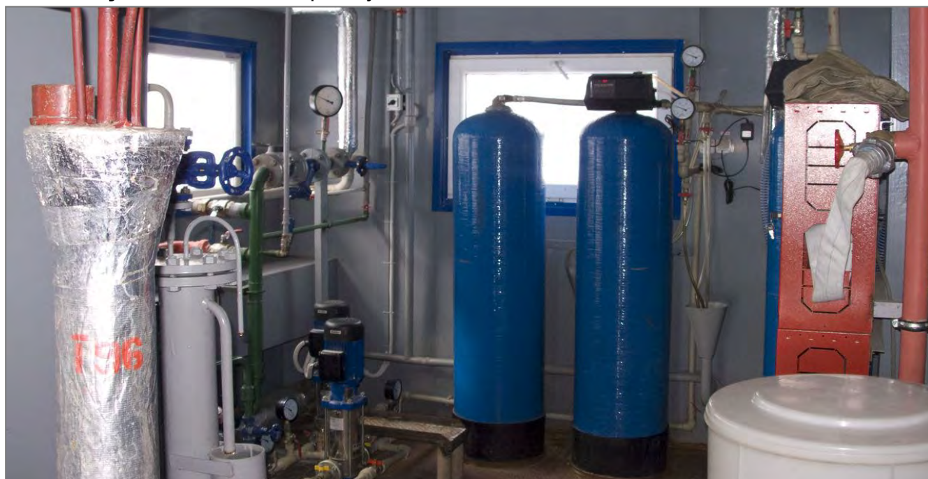
Рисунок Е.1. Станція приготування теплоносія в БМК
