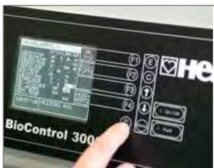
Рисунок С.3. Модуль управління автоматикою HERZ BioControl 3000
