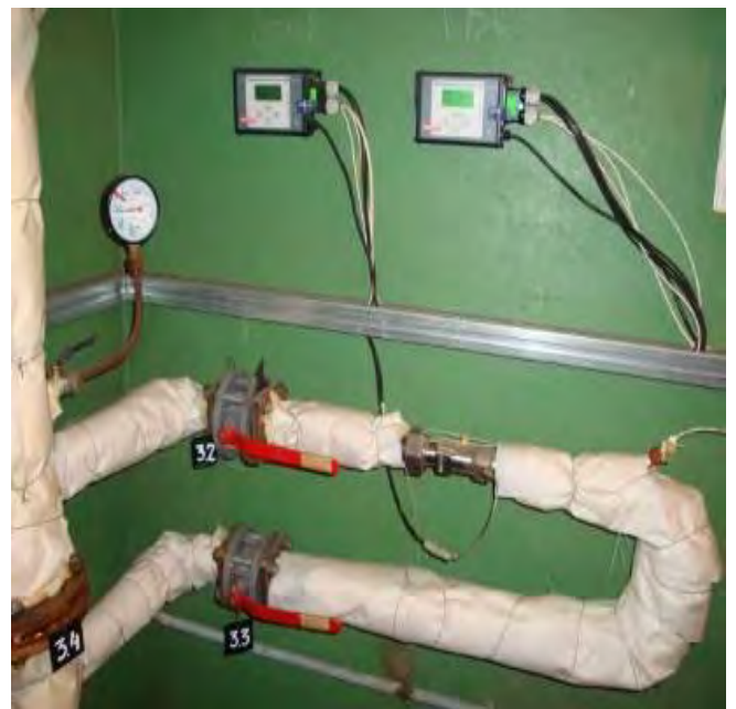
Рисунок D.3.3. Встановлення СВТУ-10М Ду 32 мм у теплопунктах житлових будівель м. Запоріжжя
