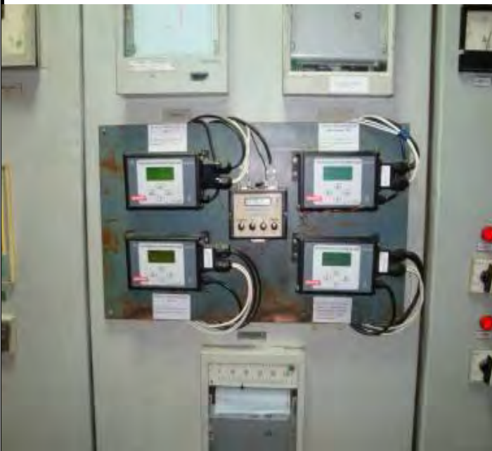
Рисунок D.3.3. Встановлення СВТУ-10М Ду 32 мм у теплопунктах житлових будівель м. Запоріжжя
