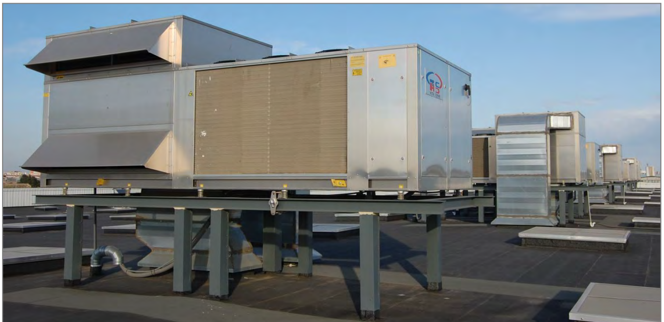
Рисунок В.1. Зовнішній вигляд теплового насоса встановленого на даху будинку
