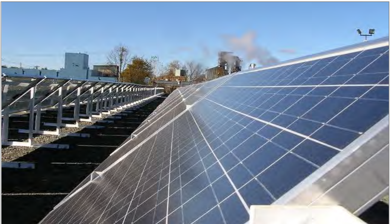
Рисунок D.1.1. Зовнішній вигляд сонячних модулів на дахах будівель
