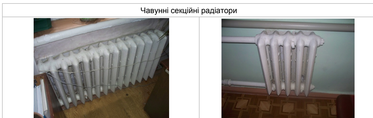
Рисунок 5.1.2. Прилади опалення будівлі
