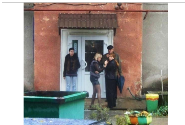
Рисунок 4.3.1. Зовнішній вигляд вхідних дверей будівлі
