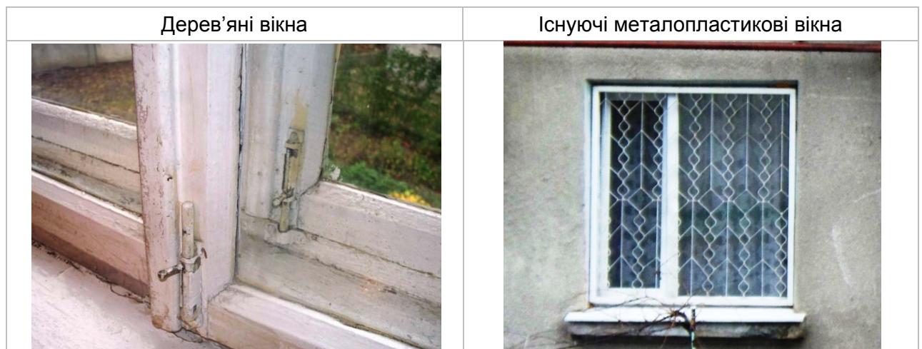
Рисунок 4.2.1. Зовнішній вигляд вікон будівлі
