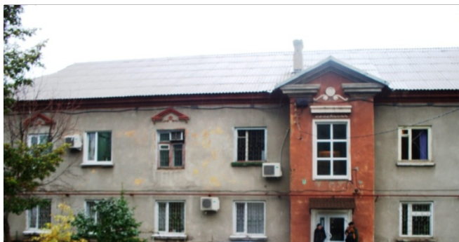
Рисунок 4.1.1. Фрагменти фасаду будівлі
