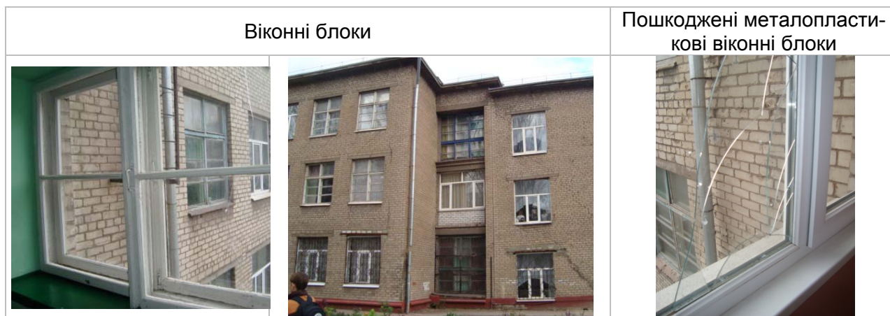
Рисунок 4.2.1. Вигляд вікон будівлі
