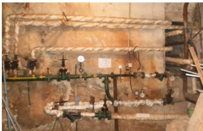
Рисунок 5.1.1. Вузол теплового введення та магістральні трубопроводи
