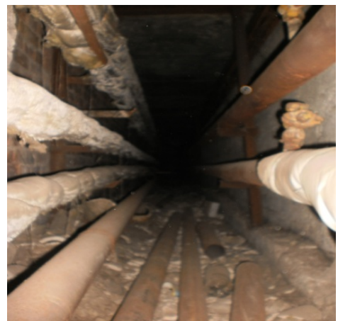
Рисунок 5.1.1. Вузол теплового введення та магістральні трубопроводи
