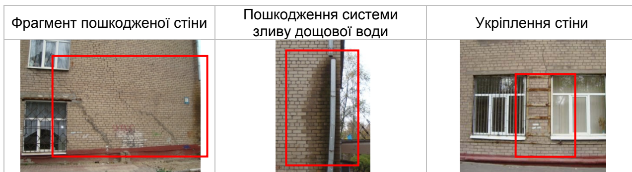
Рисунок 4.1.1. Фрагменти фасаду будівлі
