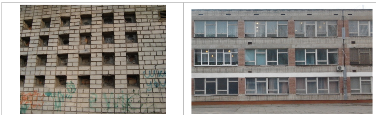
Рисунок 4.1.1. Фрагменти фасаду будівлі
