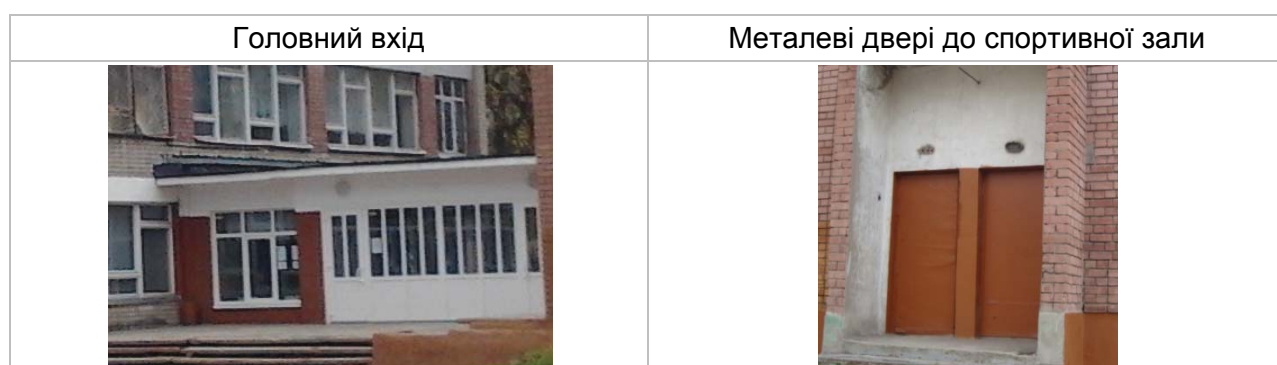
Рисунок 4.3.1. Зовнішній вигляд входних дверей будівлі
