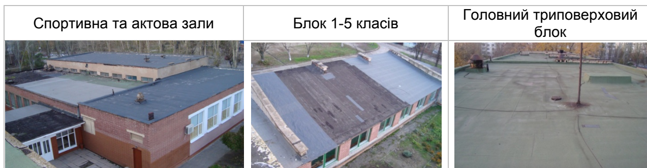
Рисунок 4.4.1. Вигляд перекриття даху та стелі
