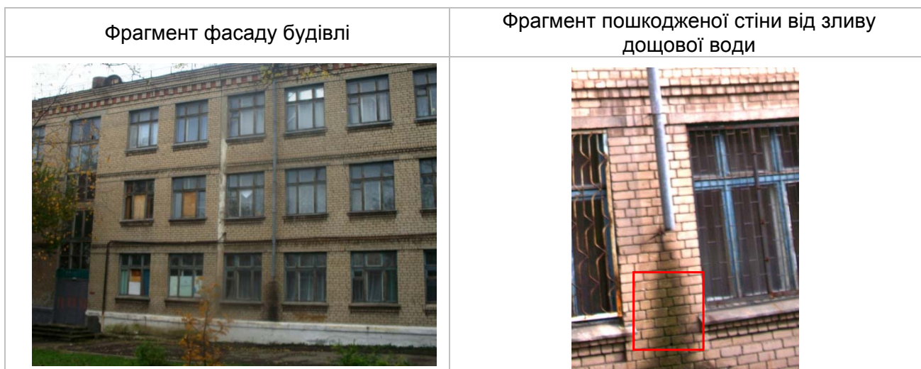
Рисунок 4.1.1. Фрагменти фасаду будівлі
