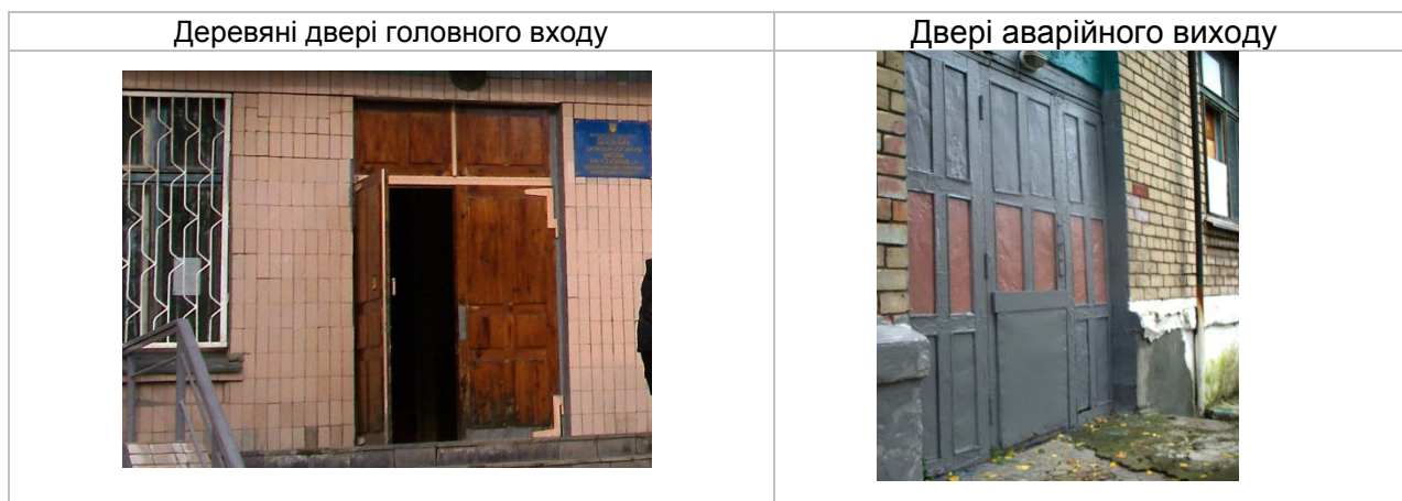
Рисунок 4.3.1. Зовнішній вигляд входних дверей будівлі
