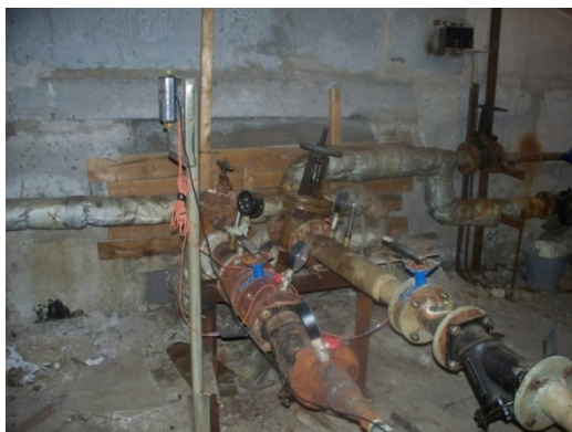
Рисунок 5.1.1. Трубопроводи в підвалі, встановлений тепловий лічильник
