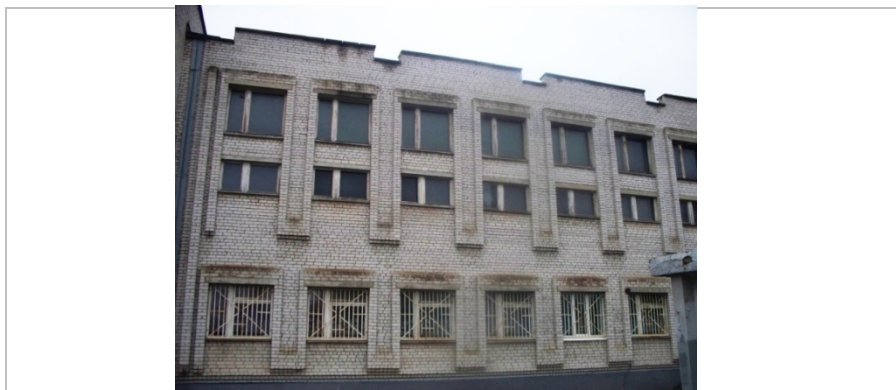
Рисунок 4.1.1. Фрагменти фасаду будівлі
