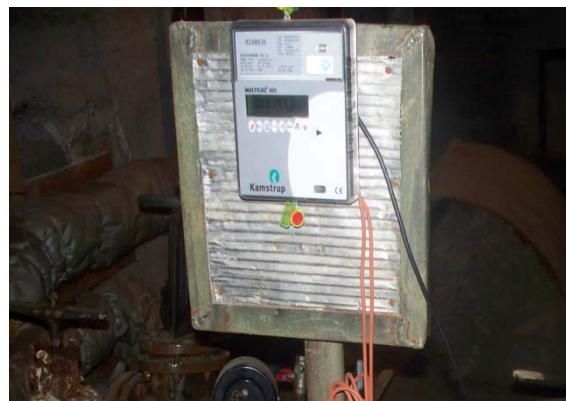
Рисунок 5.1.1. Трубопроводи в підвалі, встановлений тепловий лічильник
