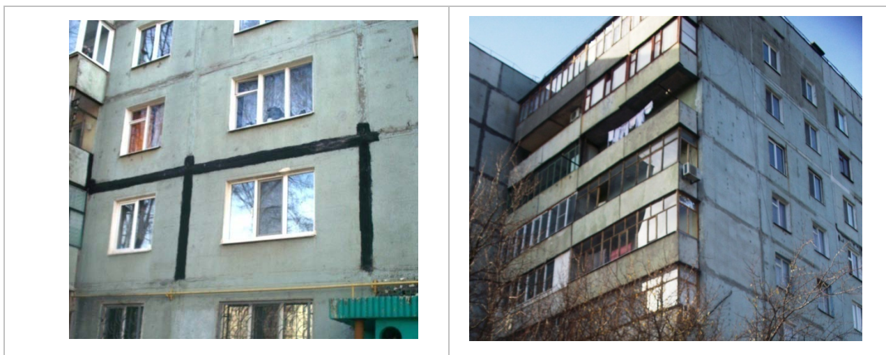
Рисунок 4.1.1. Фрагменти фасаду будівлі
