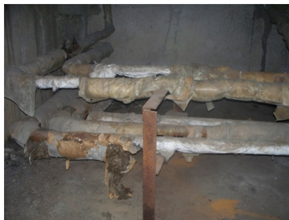
Рисунок 5.1.1. Вузол теплового введення та трубопроводи в підвалі
