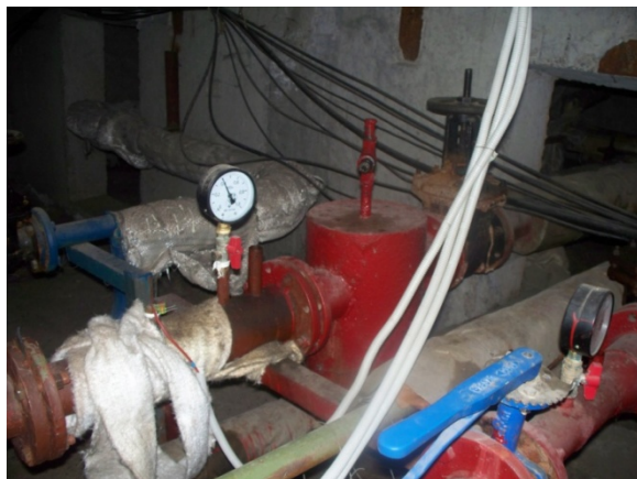
Рисунок 5.1.1. Вузол теплового введення та трубопроводи в підвалі
