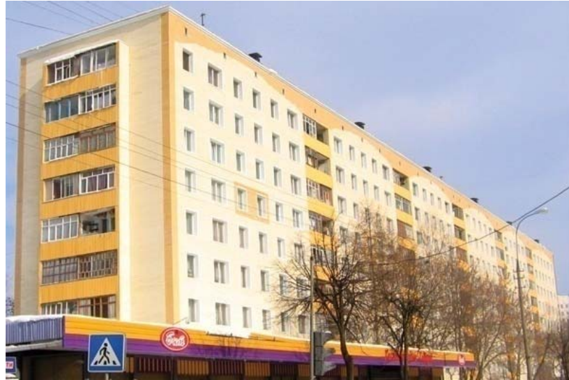
Рисунок 7.1.3. Зовнішній вигляд будівлі з системою «керамічний вентиляований фасад»
