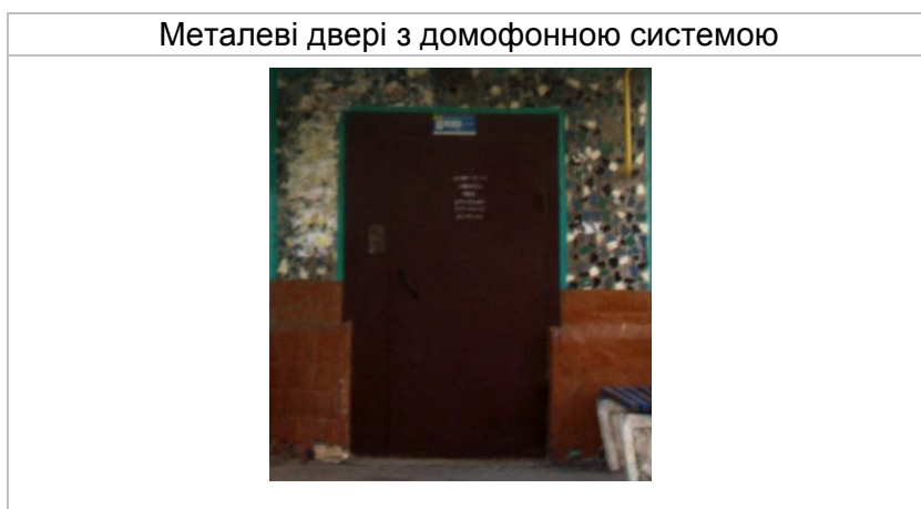
Рисунок 4.3.1. Зовнішній вигляд під'їзних дверей будівлі
