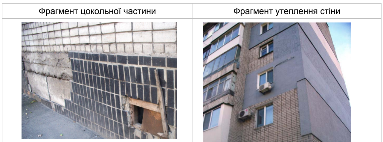
Рисунок 4.1.1. Фрагменти фасаду будівлі
