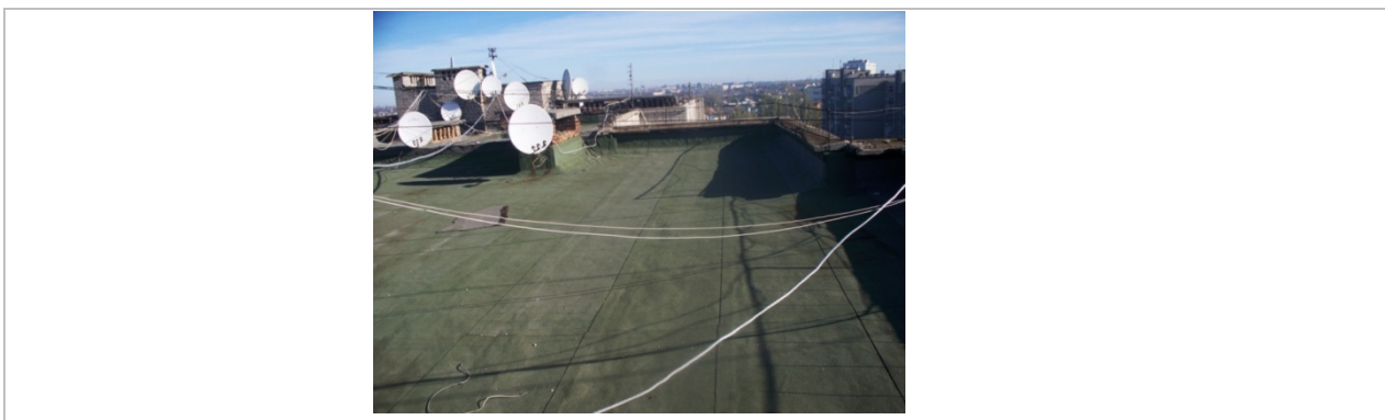
Рисунок 4.4.1. Зовнішній вигляд перекриття даху
