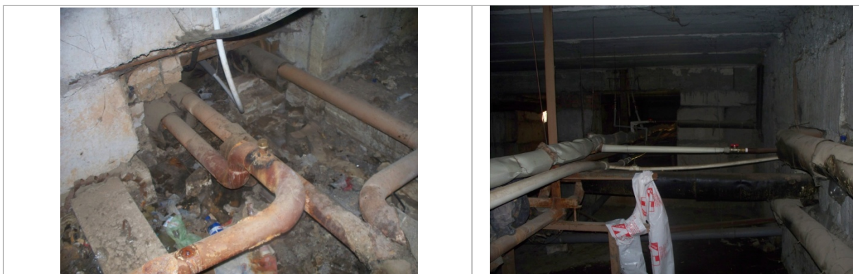
Рисунок 5.1.1. Трубопроводи в підвалі будівлі
