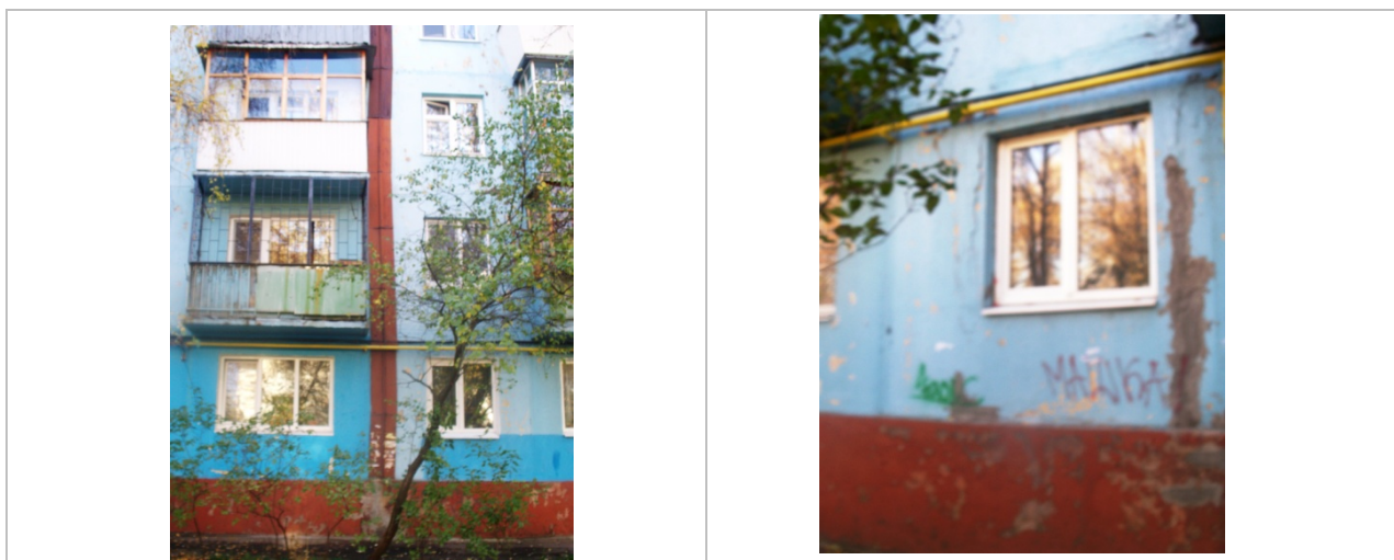
Рисунок 4.1.1. Фрагменти фасаду будівлі
