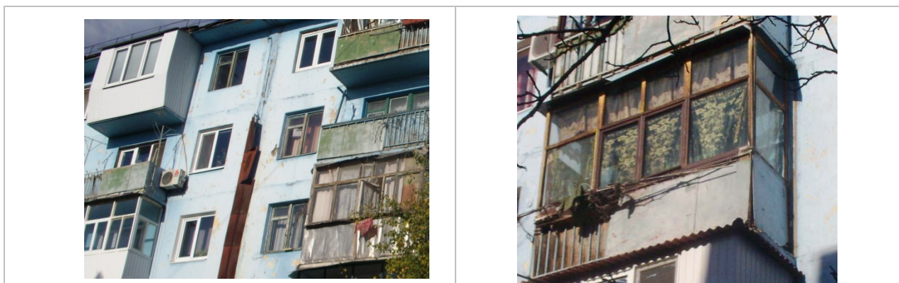
Рисунок 4.2.1. Зовнішній вигляд віконних та балконних блоків будівлі
