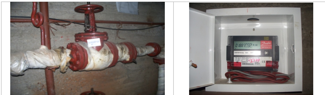
Рисунок 5.1.1. Трубопровод в підвалі та встановлений лічильник тепла
