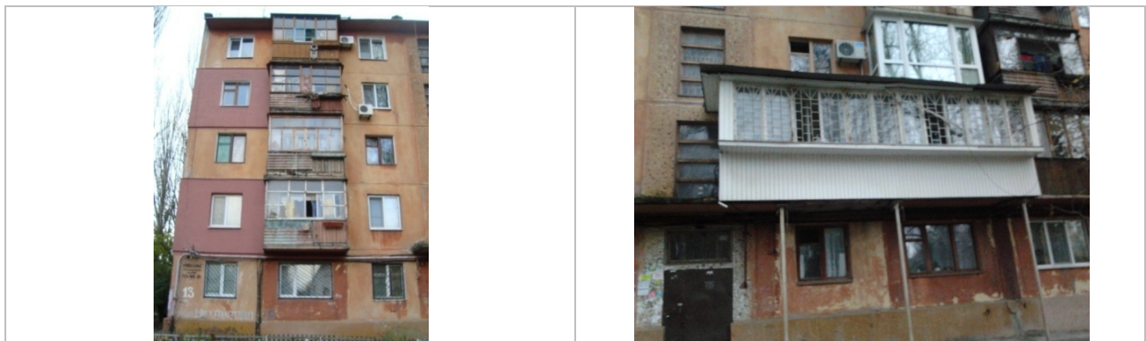
Рисунок 4.2.1. Зовнішній вигляд віконних та балконних блоків будівлі
