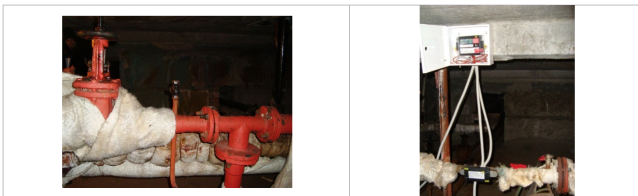
Рисунок 5.1.1. Вузол теплового введення та встановлений тепловий лічильник
