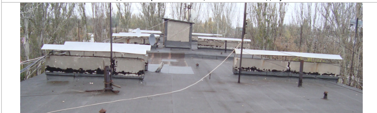
Виведення збірних вентиляційних каналів на даху
