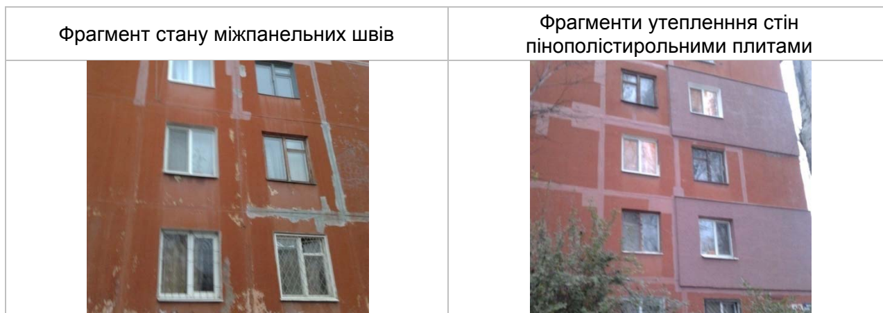
Рисунок 4.1.1. Фрагменти фасаду будівлі
