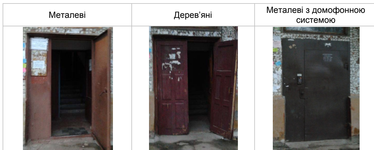
Рисунок 4.3.1. Зовнішній вигляд під'їзних дверей будівлі
