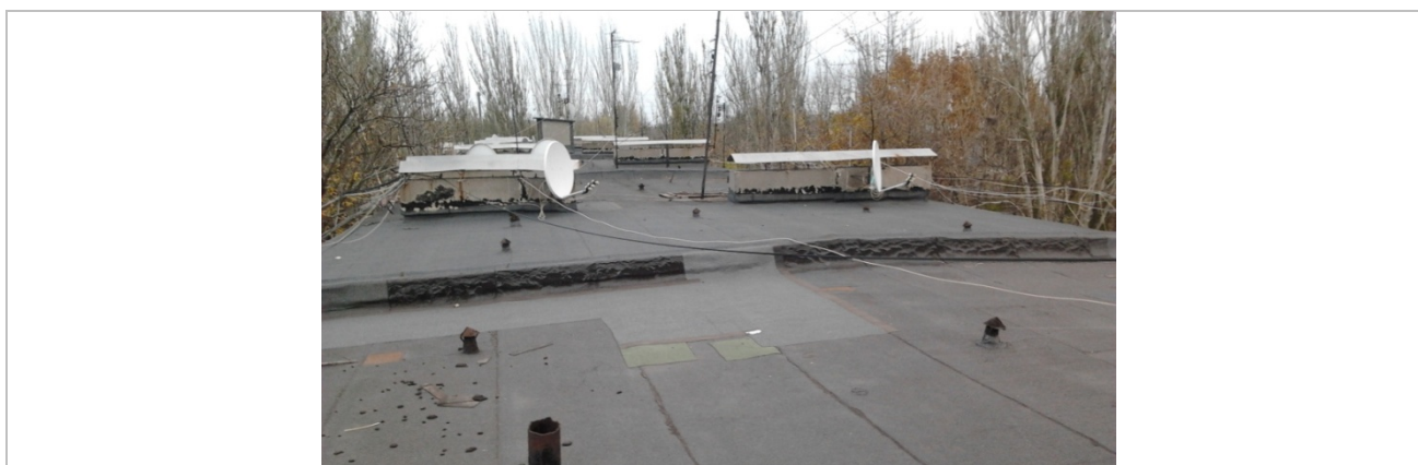
Рисунок 4.4.1. Зовнішній вигляд перекриття даху
