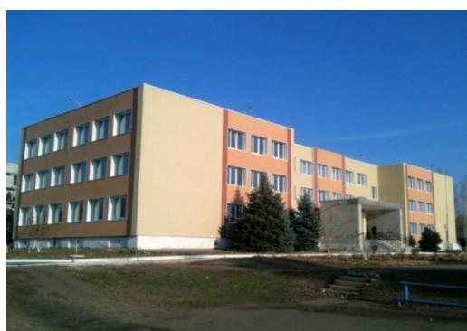
**Рисунок 7.1.3.** Утеплення стін за методом «керамічний вентильований фасад»
