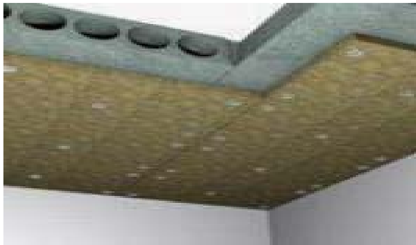
Рисунок 7.1.5. Приклад утеплення перекриття зі сторони підвалу
