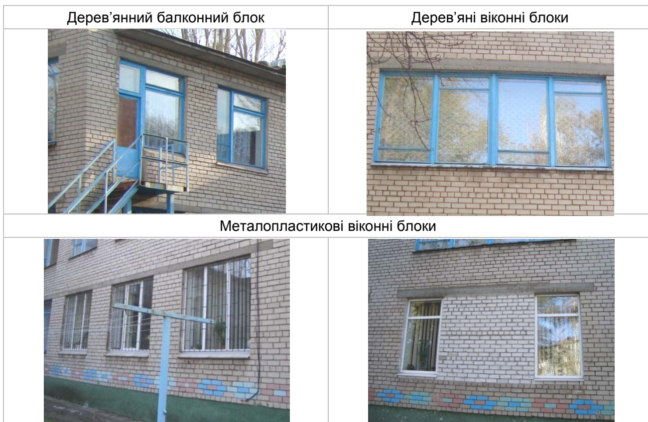
Рисунок 4.2.1. Вигляд вікон будівлі
