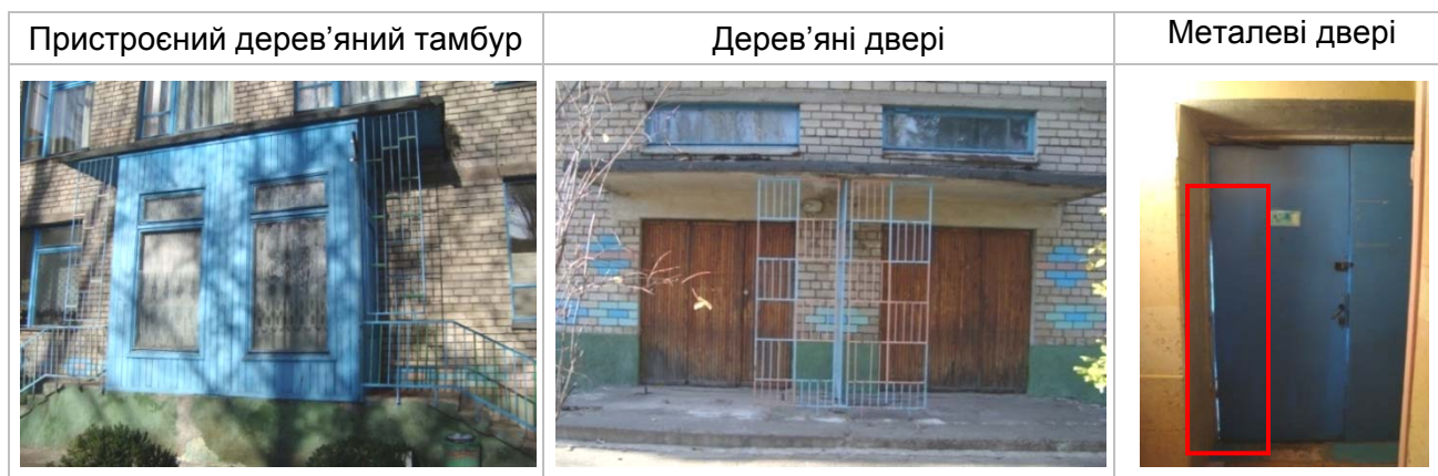
Рисунок 4.3.1. Зовнішній вигляд входних дверей будівлі
