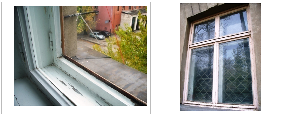
Рисунок 4.2.1. Зовнішній вигляд вікон будівлі
