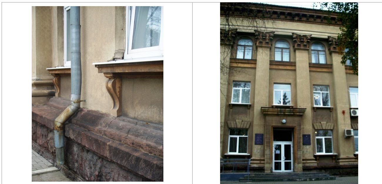
Рисунок 4.1.1. Фрагменти фасаду будівлі
