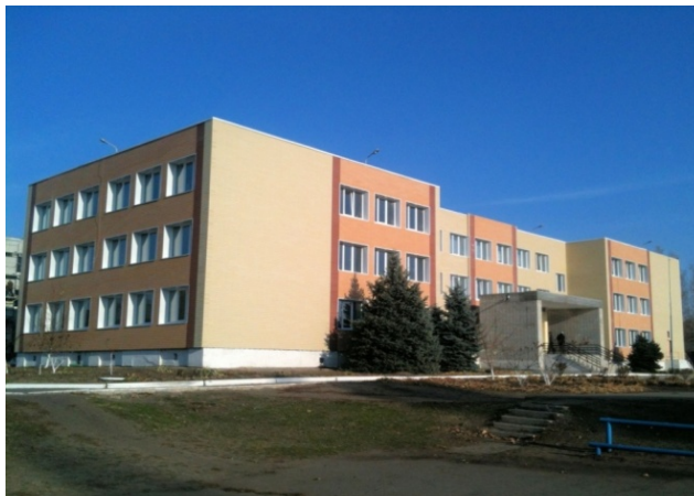
Рисунок 7.1.3. Утеплення стін за методом «вентилюваний фасад»
