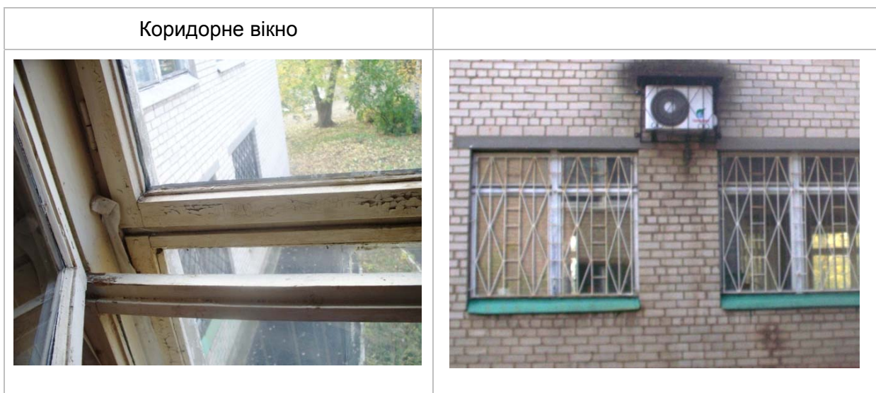
Рисунок 4.2.1. Зовнішній вигляд вікон будівлі
