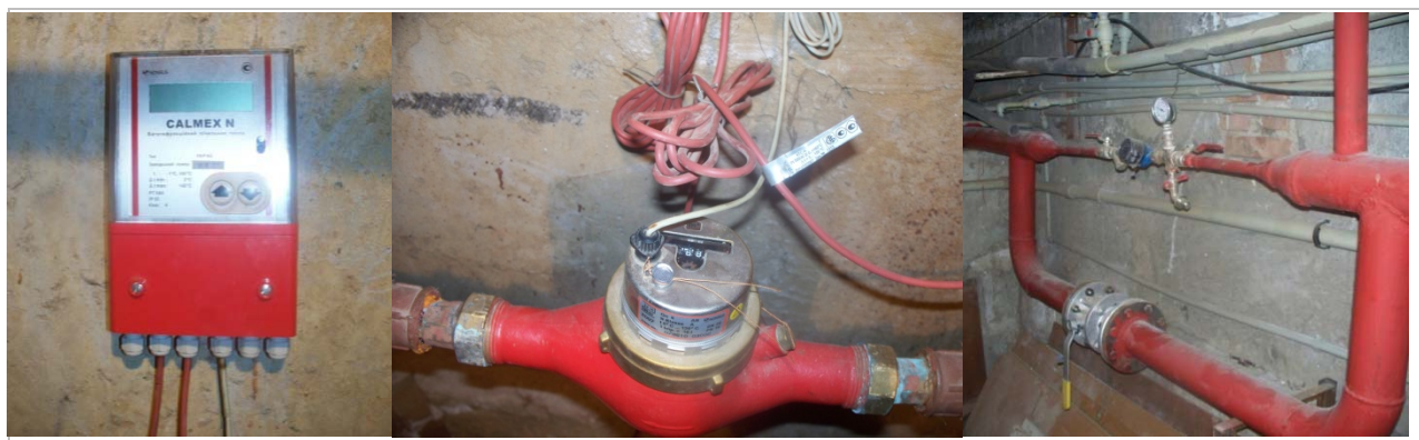
Рисунок 5.1.2. Вузол теплового ведення
