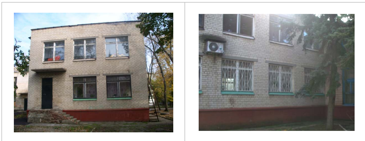
Рисунок 4.1.1. Фрагменти фасаду будівлі
