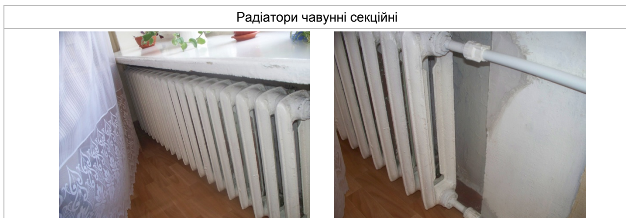
Рисунок 5.1.2. Вузол теплового ведення
