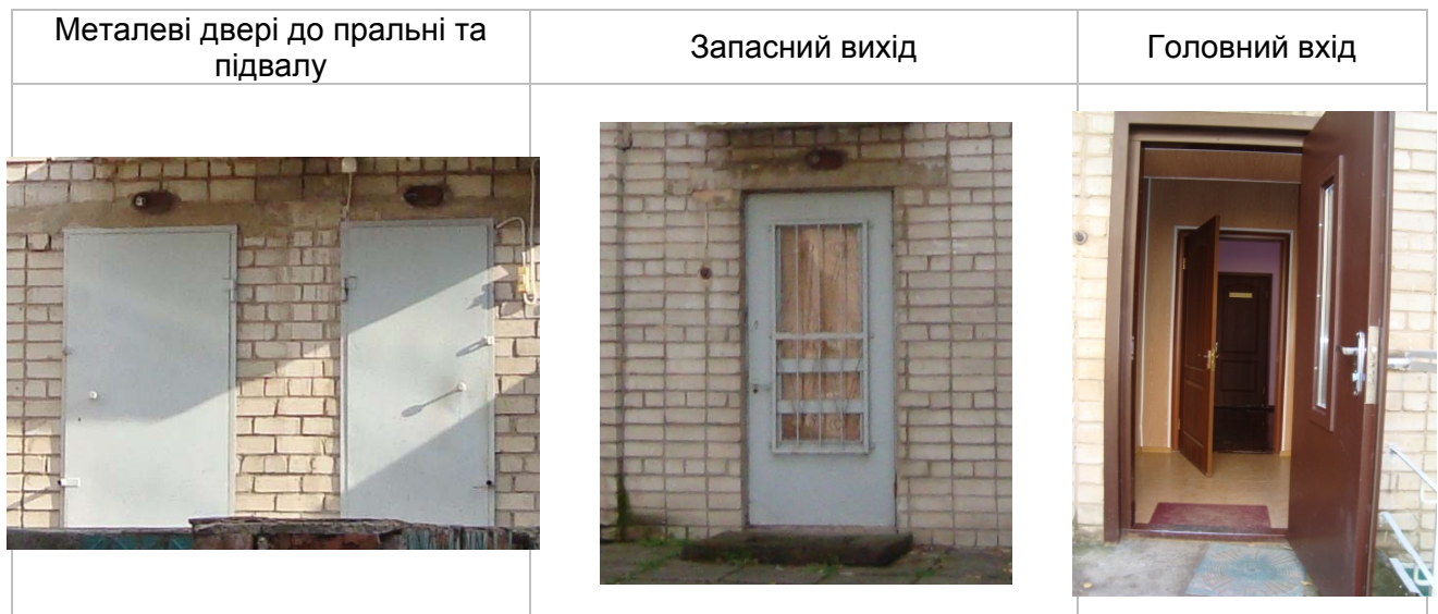
Рисунок 4.3.1. Зовнішній вигляд входних дверей будівлі
