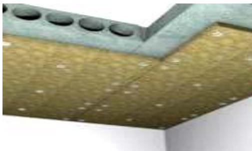
Рисунок 7.1.5. Приклад утеплення перекриття зі сторони підвалу
