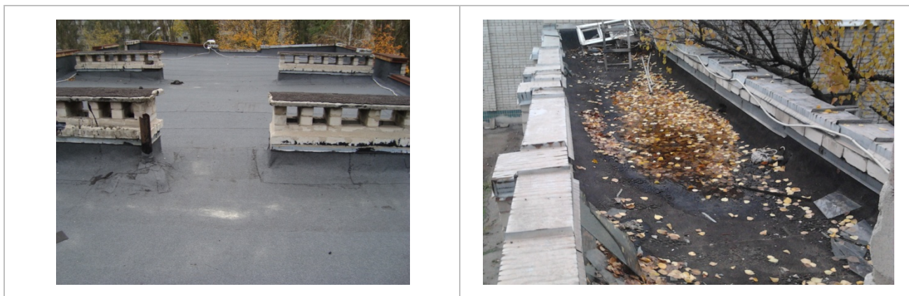
Рисунок 4.4.1. Вигляд перекриття даху
