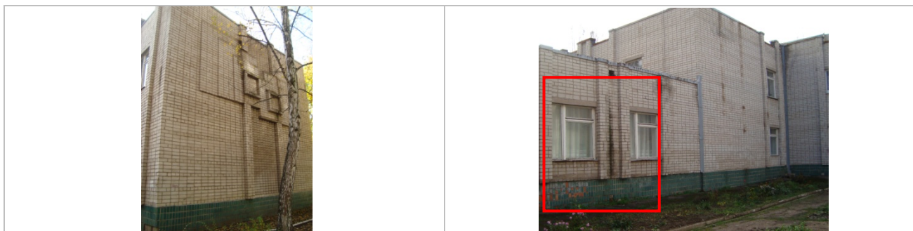
Рисунок 4.1.1. Фрагменти фасаду будівлі
