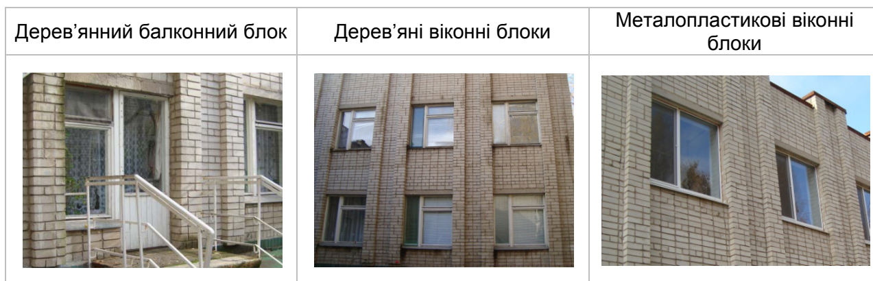
Рисунок 4.2.1. Вигляд вікон будівлі
