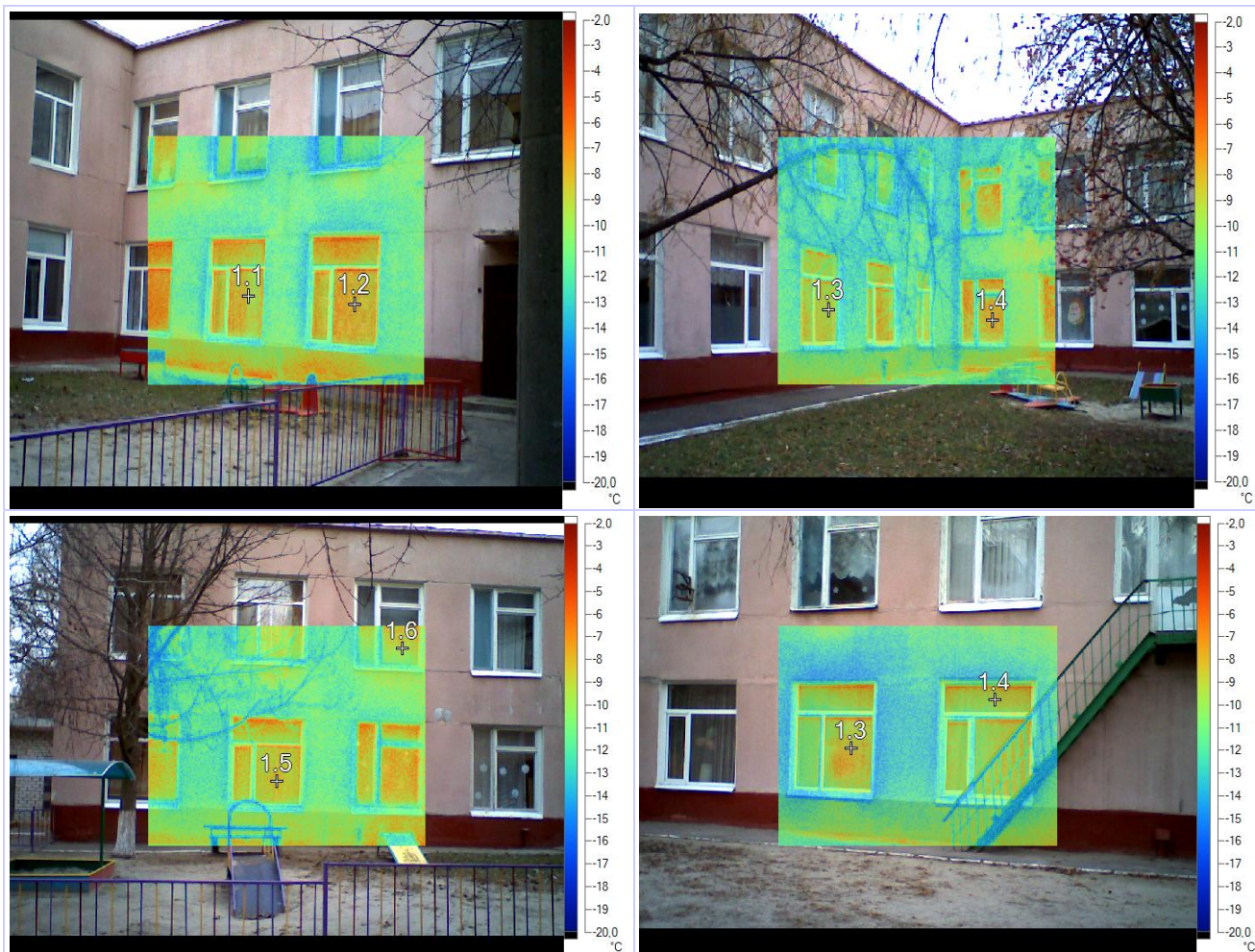
Рисунок 2. Фотографії фрагментів віконних конструкцій.
