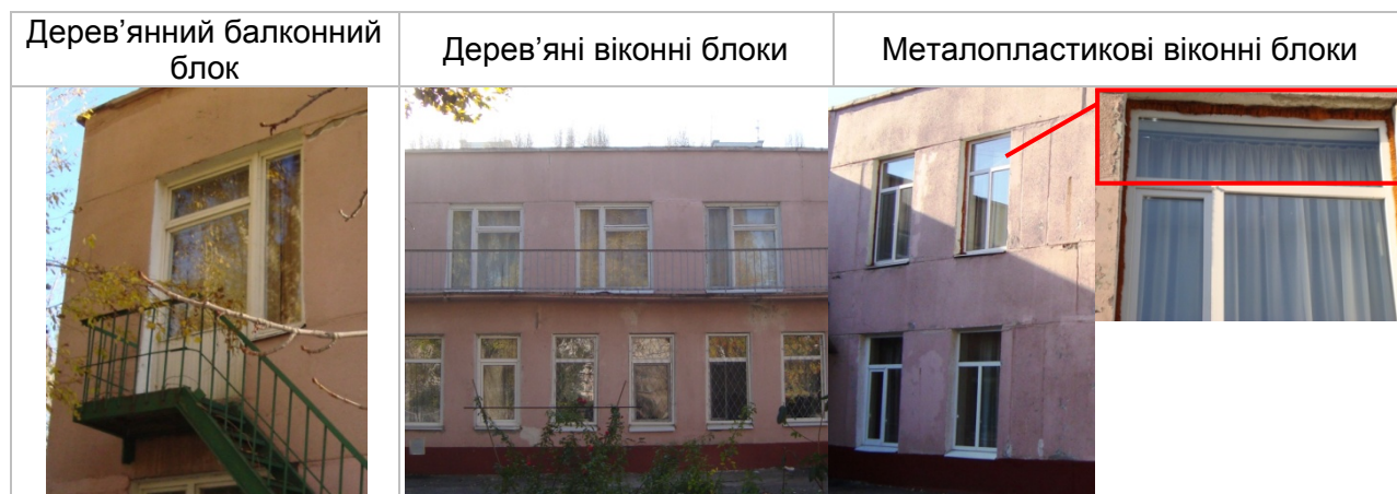
Рисунок 4.2.1. Вигляд вікон будівлі
