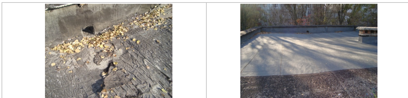
Рисунок 4.4.1. Вигляд перекриття даху
