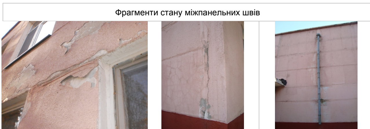
Рисунок 4.1.1. Фрагменти фасаду будівлі
