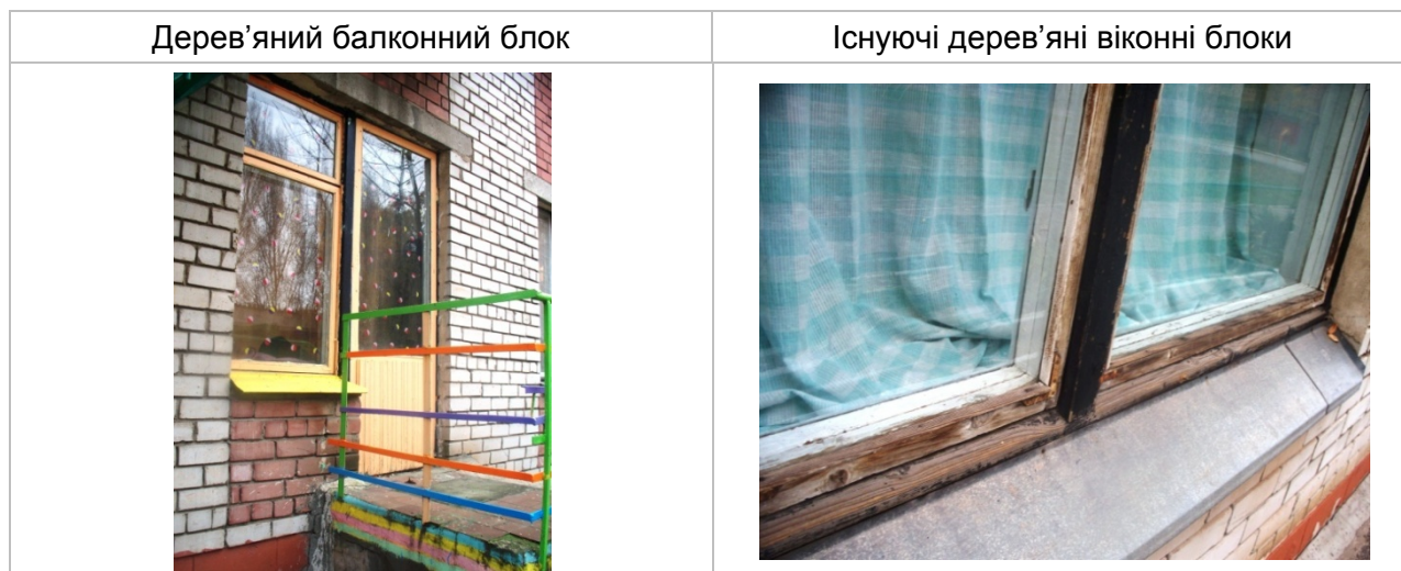
Рисунок 4.2.1. Зовнішній вигляд вікон будівлі
