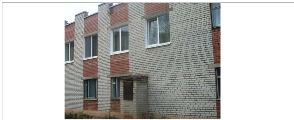
Рисунок 4.1.1. Фрагменти фасаду будівлі
