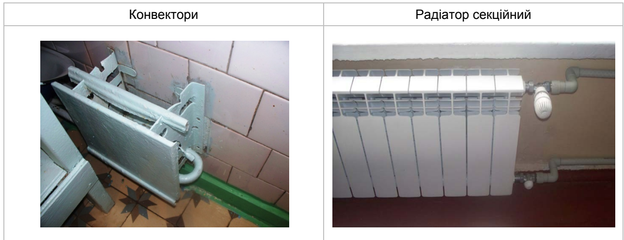
Рисунок 5.1.2. Прилади опалення будівлі
