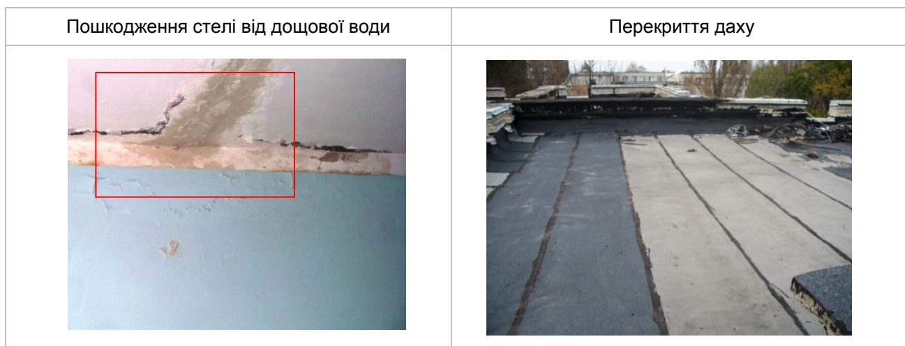
Рисунок 4.4.1. Зовнішній вигляд перекриття даху
