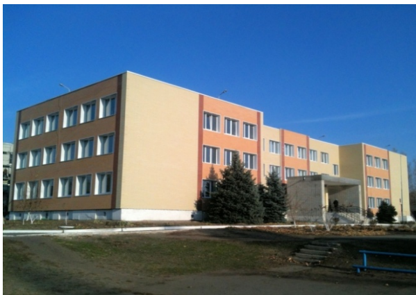
Рисунок 7.1.2. Зовнішній вигляд будівлі ЗОШ №19 м. Павлограда
