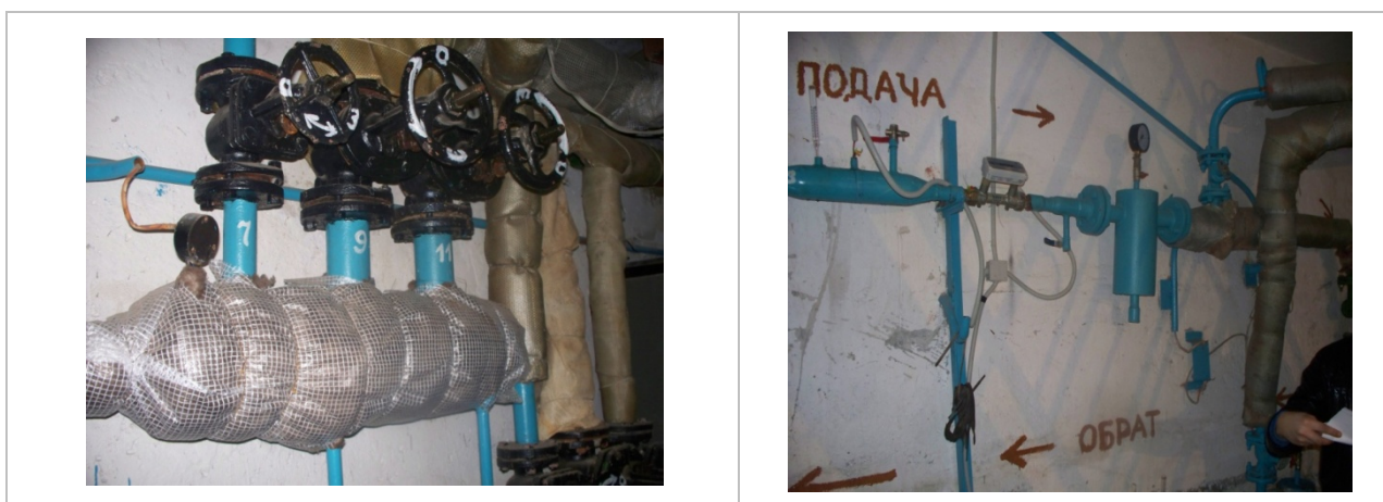
Рисунок 5.1.1. Вузол теплового введення
