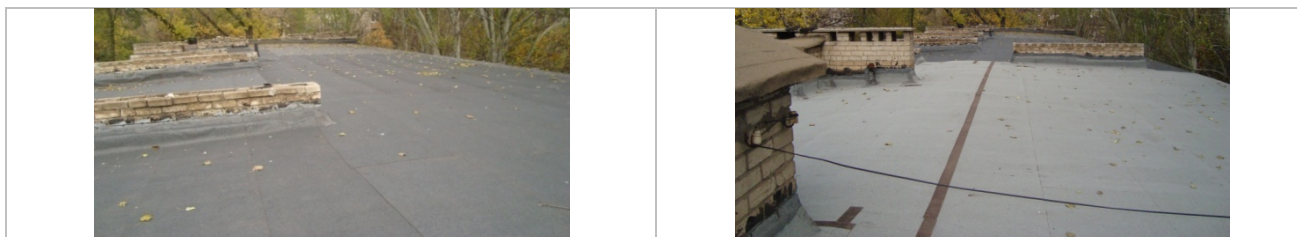
Рисунок 4.4.1. Вигляд перекриття даху
