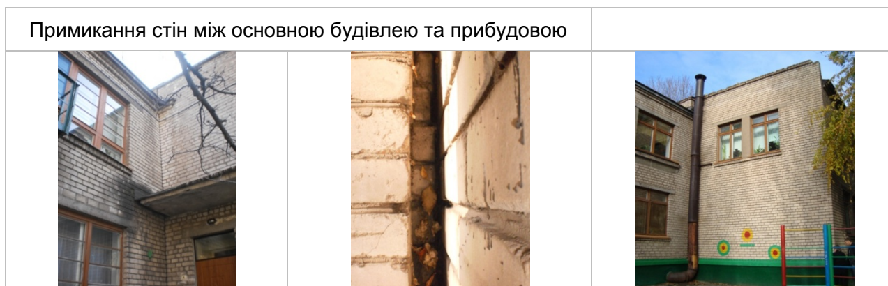
Рисунок 4.1.1. Фрагменти фасаду будівлі
