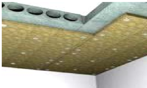
Рисунок 7.1.5. Приклад утеплення перекриття зі сторони підвалу
