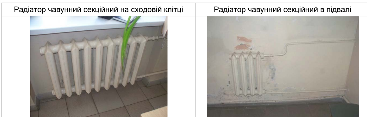
Рисунок 5.1.2. Прилади опалення будівлі
