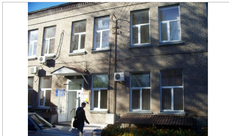
Рисунок 4.2.1. Вигляд вікон будівлі
