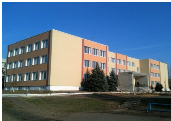
Рисунок 7.1.2. Зовнішній вигляд будівлі ЗОШ №19 м. Павлограда
