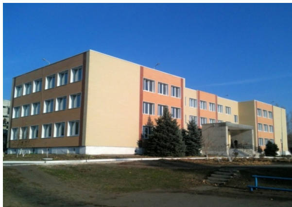
Рисунок 7.1.2. Зовнішній вигляд будівлі ЗОШ №19 м. Павлограда
