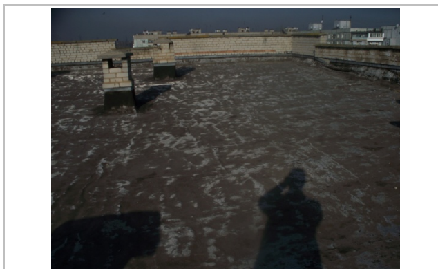
Рисунок 4.4.1. Вигляд перекриття даху
