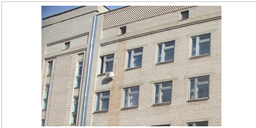
Рисунок 4.1.1. Фрагменти фасаду будівлі
