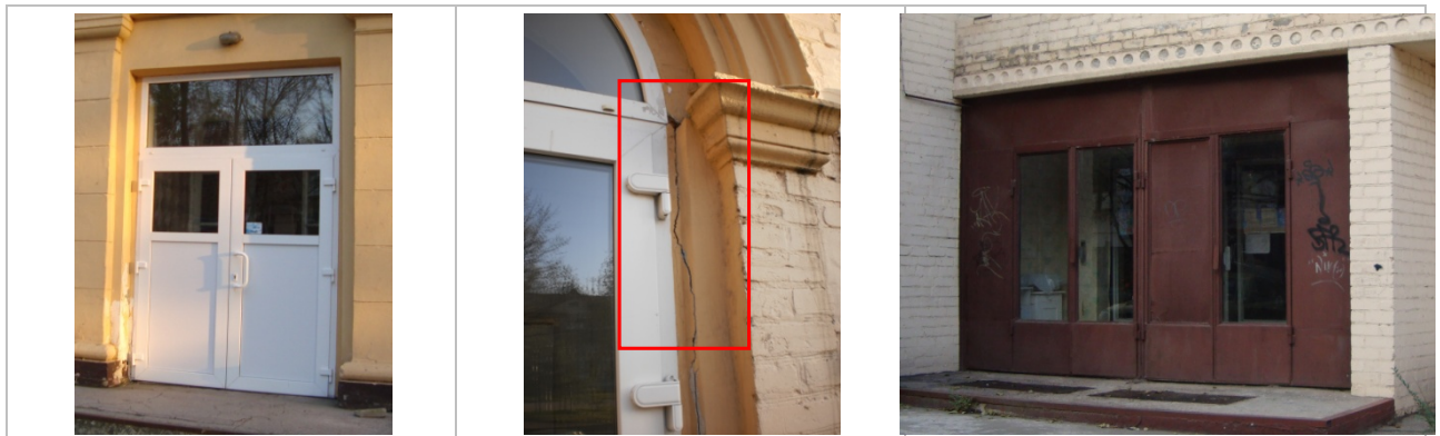
Рисунок 4.3.1. Зовнішній вигляд входних дверей будівель
