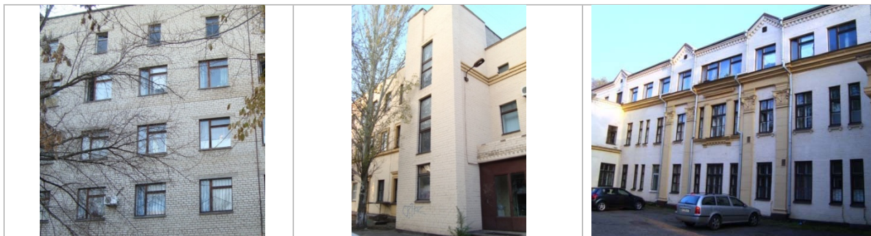
Рисунок 4.2.1. Вигляд вікон будівель
