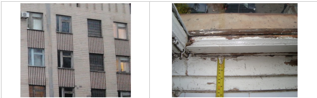
Рисунок 4.2.1. Вигляд вікон будівлі
