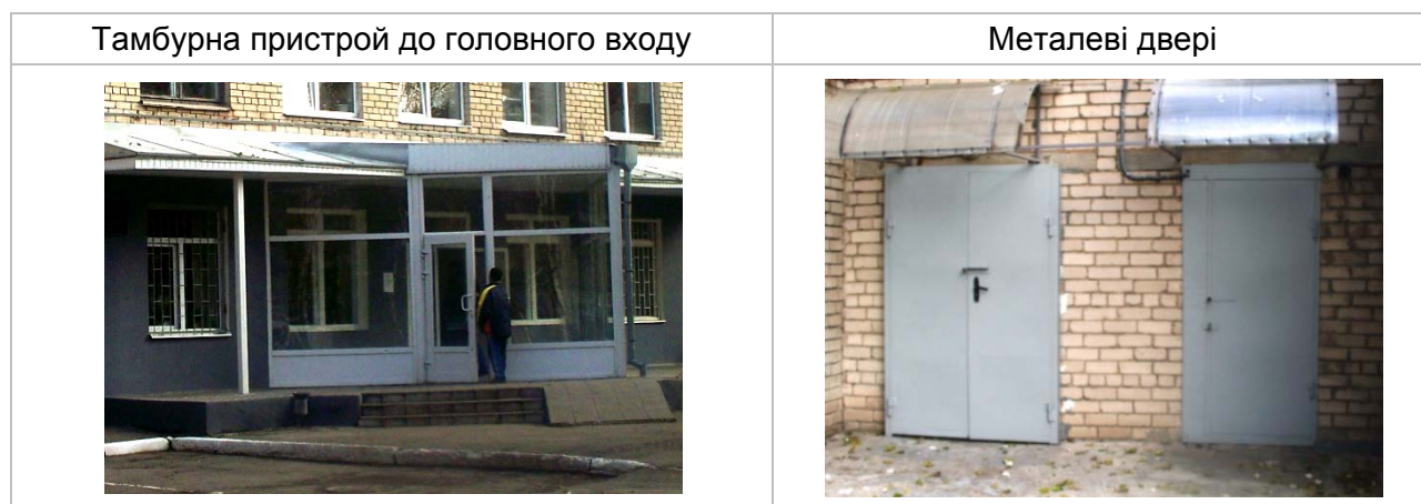
Рисунок 4.3.1. Зовнішній вигляд вхідних дверей будівлі
