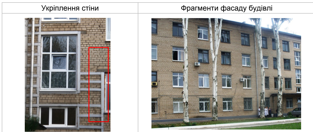
Рисунок 4.1.1. Фрагменти фасаду будівлі
