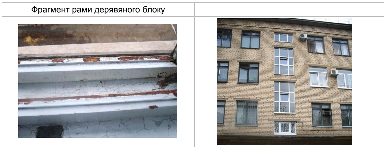
Рисунок 4.2.1. Вигляд вікон будівлі
