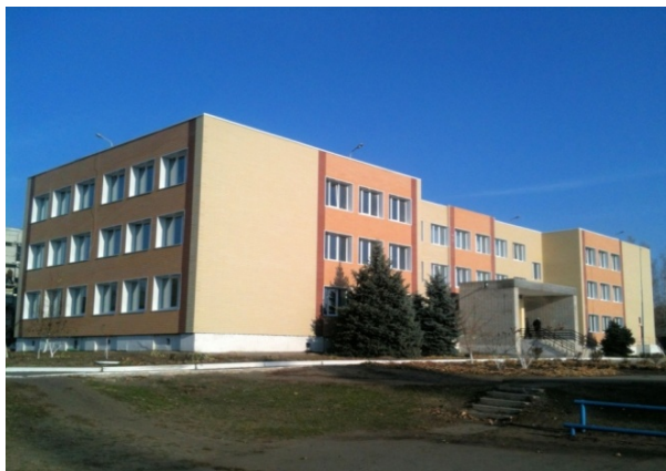
Рисунок 7.1.2. Зовнішній вигляд будівлі ЗОШ №19 м. Павлограда
