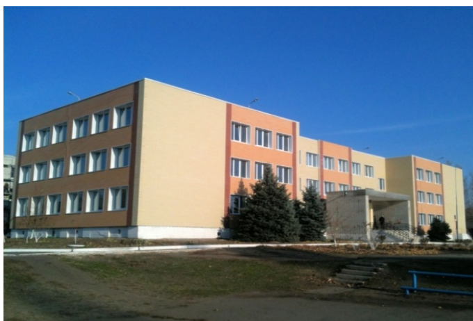
Рисунок 7.1.3. Утеплення стін за методом «керамічний вентиляований фасад»
