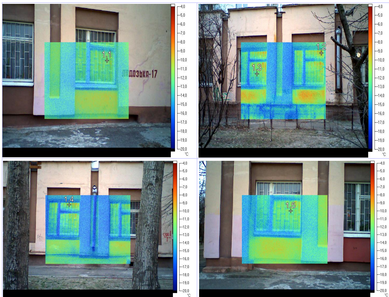
Рисунок 2. Фотографії фрагментів віконних конструкцій.
