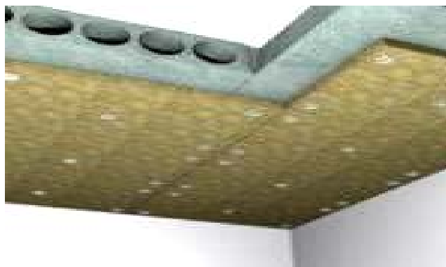
Рисунок 7.1.5. Приклад утеплення перекриття зі сторони підвалу
