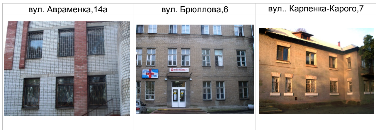
Рисунок 4.2.1. Вигляд вікон будівлі
