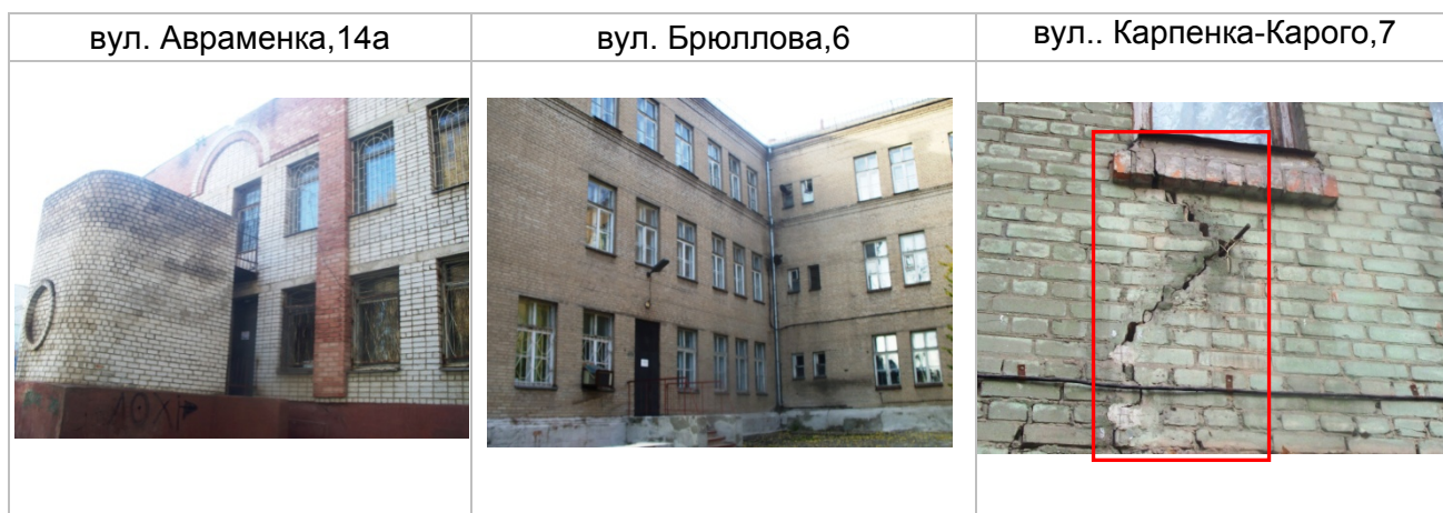
Рисунок 4.1.1. Фрагменти фасаду будівлі
